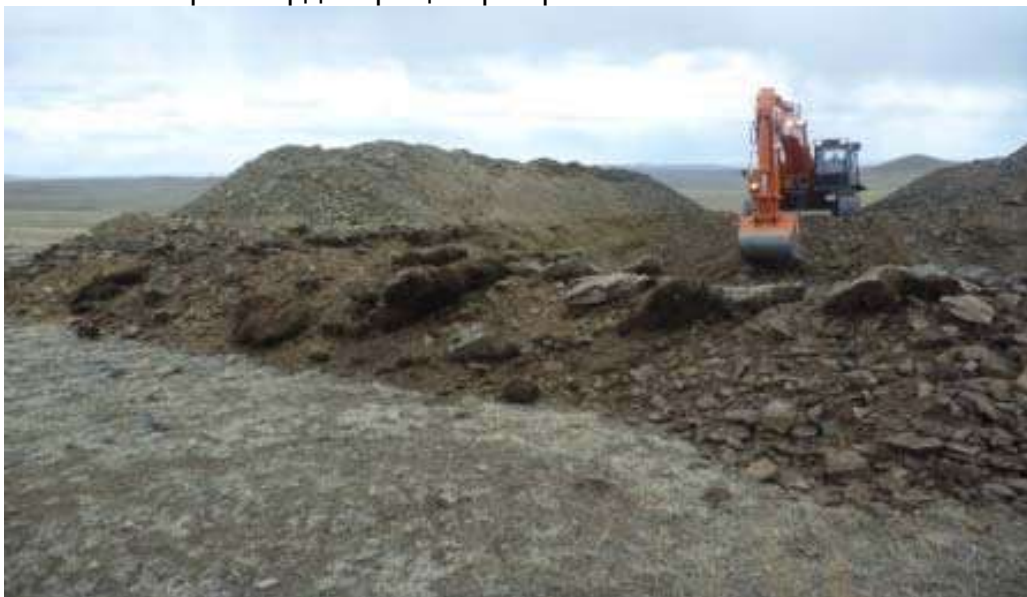
Зураг 20. Паркын газар шорооны ажил хийж буй байдал
