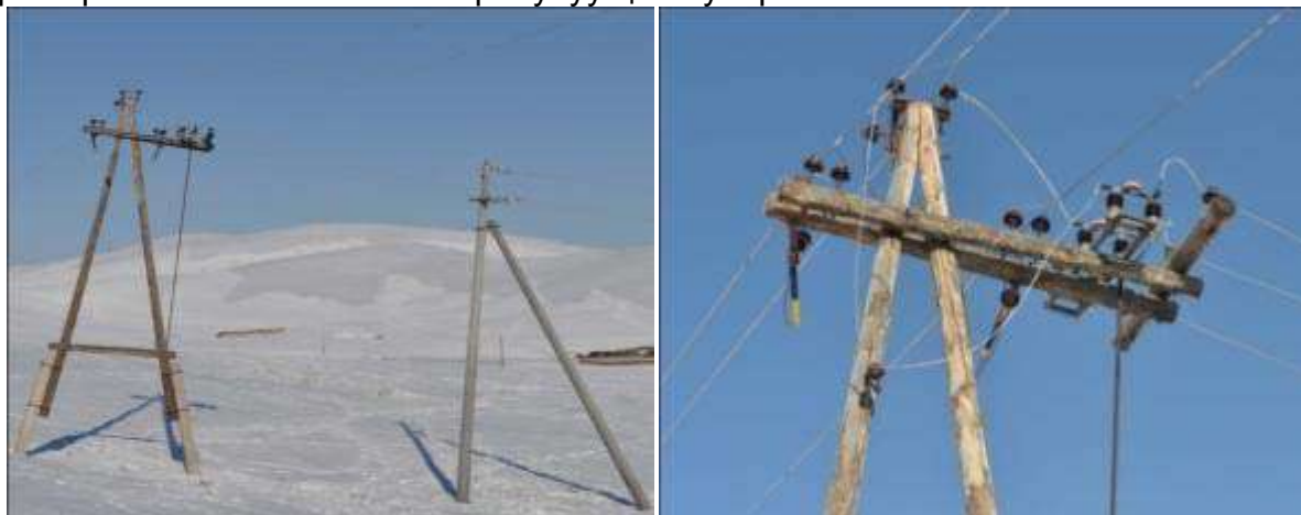
Зураг 34. 15 квт-ын Өндөр хүчдэлийн шугамын шувуу тогонд цохиулж үхдэг хэсэг
