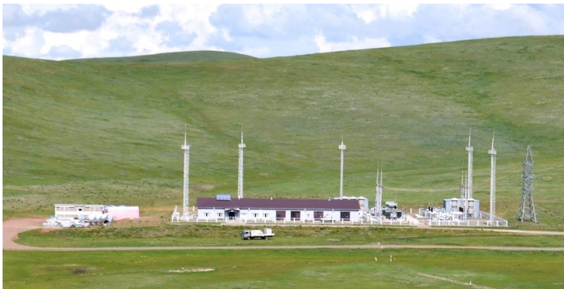
1.2-р зураг. СЦС-ын удирдлагын байр, дэд станц
