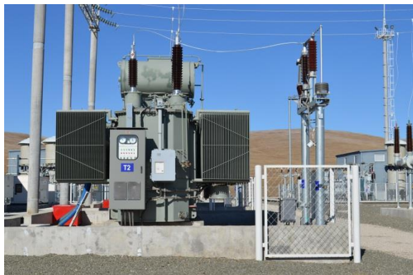
1.12-р зураг. 110/35 кВ 50 МВА-ын Трансформатор /нүүрэн тал ба зүүн талаас, 2 ширхэг/
