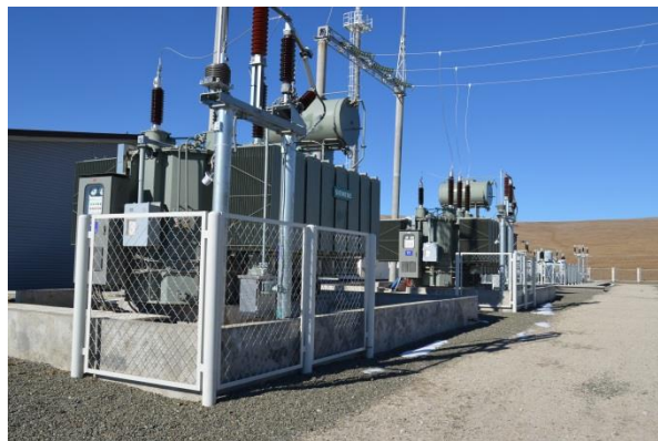
1.12-р зураг. 110/35 кВ 50 МВА-ын Трансформатор /нүүрэн тал ба зүүн талаас, 2 ширхэг/
