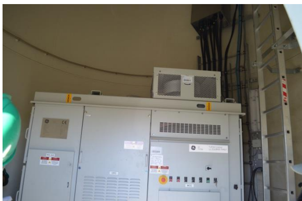
1.4-р зураг. Цамхаг доторх инвертер
