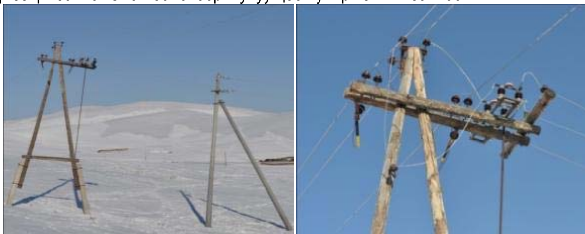
Зураг 34. 15 квт-ын Өндөр хүчдэлийн шугамын шувуу тогонд цохуулж үхдэг хэсэг
