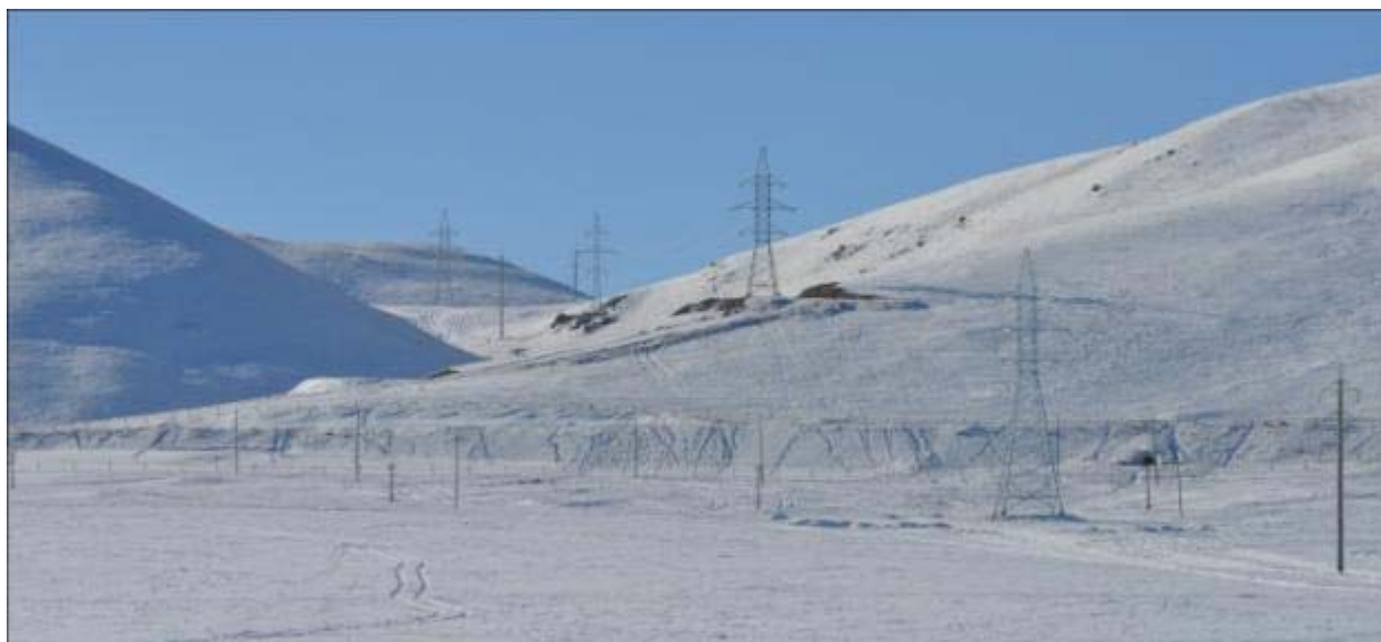
Зураг 30. Салхитын дэд станцаас Налайх хүртэл 110 мянган квт-ын өндөр хүчдэлийг дамжуулах шугам
