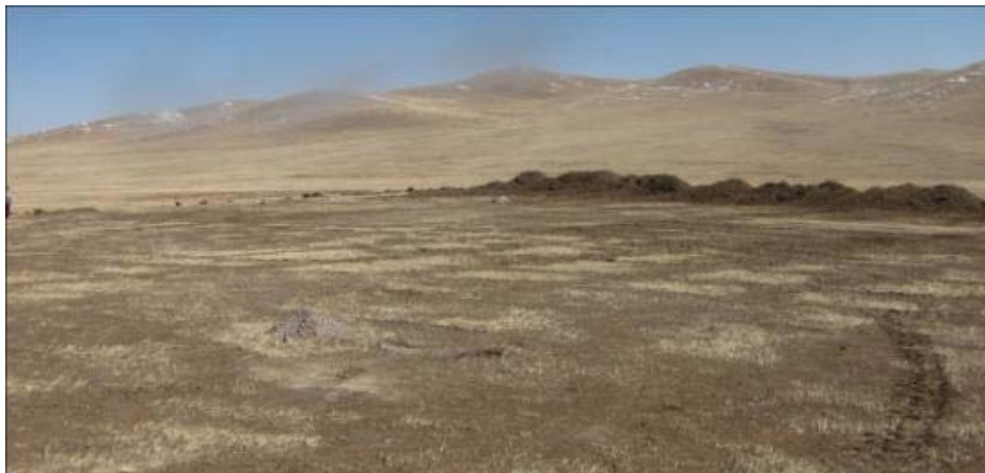
Зураг 45. Замын дагуу хөрсний өнгөн хэсгийн хусаж тэгшлэх ажил
